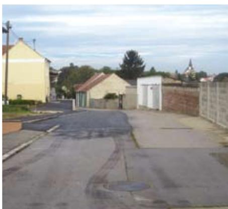
Die Wagenklatferstraße erhielt eine Verschleißdecke und neue Beleuchtungskörper.
